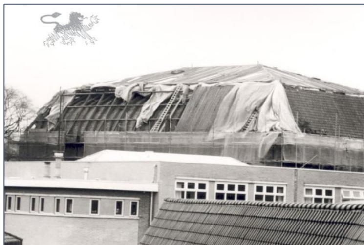
Figuur 12; Afbraak van de oude kap van de Westerkerk (Afbraak van de oude kap van de Westerkerk, 1991)
