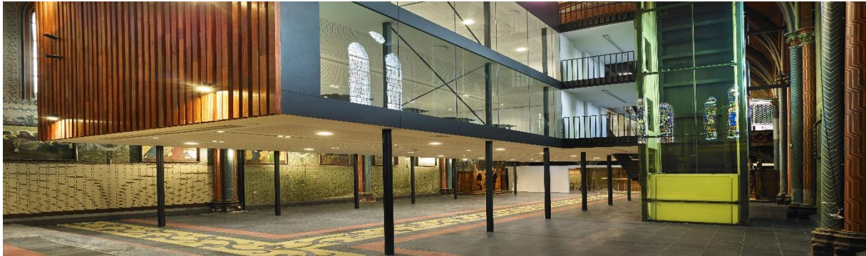
Figuur 16; Box in box constructie in Broederschool Sint-Niklaas (Sint-Niklaas, 2017)
