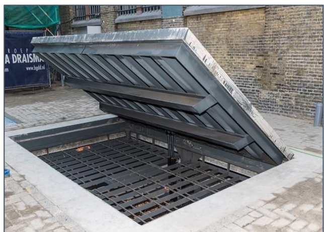
Figuur 25; De bunker voor de biomassa (Dalen, 2016)
