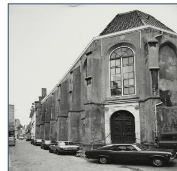
Figuur 3; Westerkerk Leeuwarden (N.H. kerk (Westerkerk), 1979)
